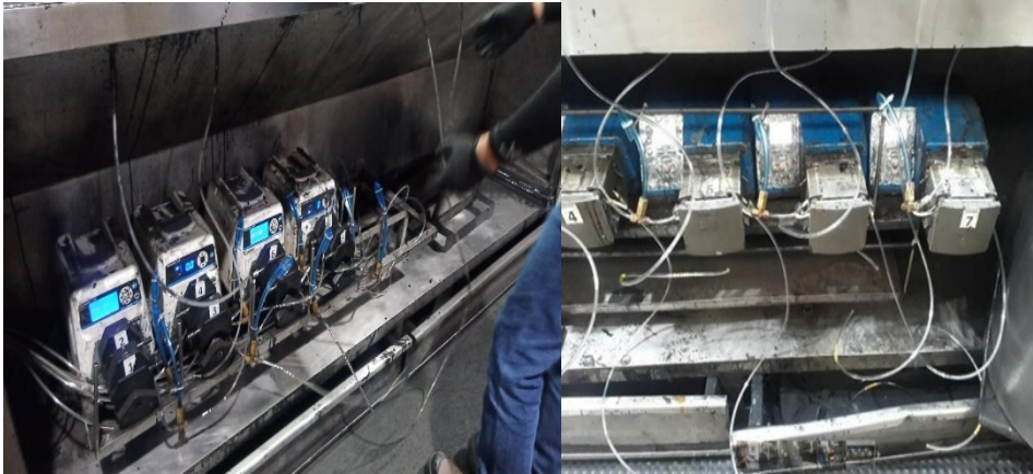
Ilustración 53 Cambio de mangueras de Coating Apagado de la cabina del plasma Cooper Standard. Fuente: Elaboración propia, 2022
