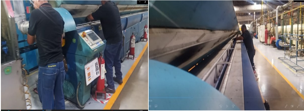
Ilustración 88 Segunda sección de hornos (curado de coating) Cooper Standard. Fuente: Elaboración propia, 2022
